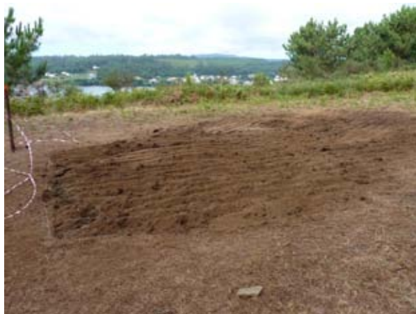
Proceso de tapado das catas escavadas
